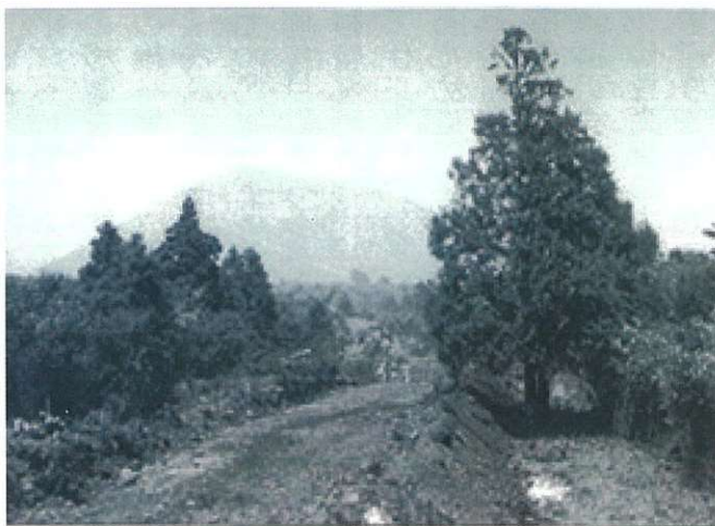
分譲地造成が始まった頃の伊豆高原
