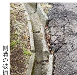
横断側溝のひび割れ
