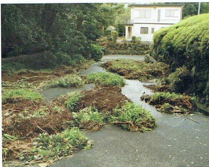
敷地のがけが崩れて道路に土砂が流れ込み通行止めに
