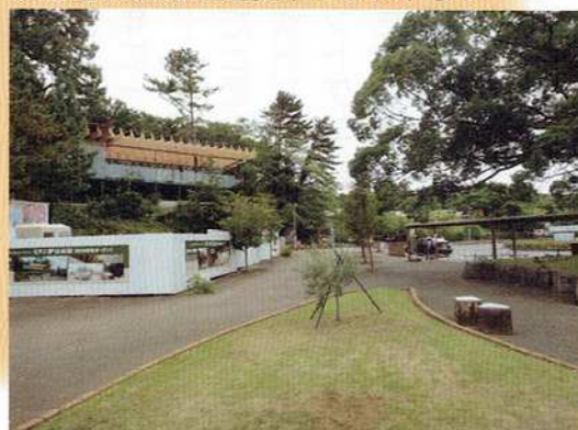
伊豆高原駅前に建設中のレストラン
