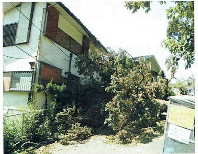
庭の木が倒れて隣家の2階の屋根を壊して隣地に倒れこんだ
